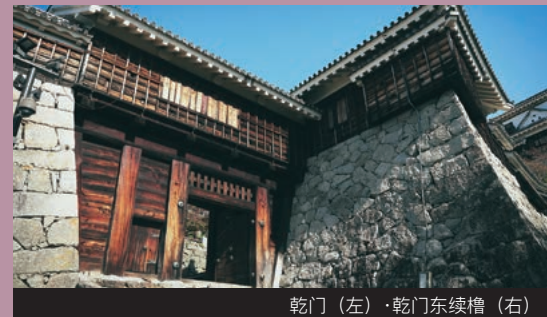
乾门（左）・乾门东续櫓（右）
