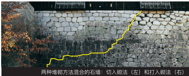
两种堆砌方法混合的石墙：切入砌法（左）和打入砌法（右）
