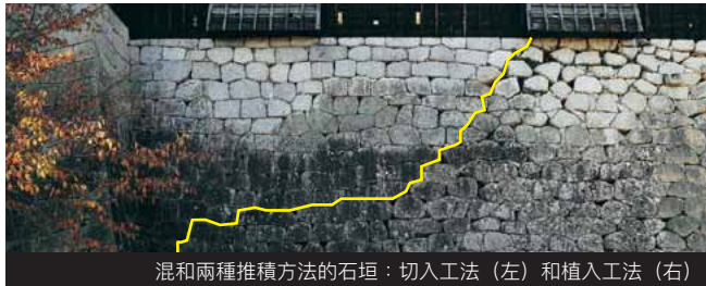
混和兩種推積方法的石垣：切入工法（左）和植入工法（右）
