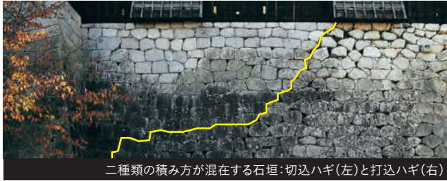
二種類の積み方が混在する石垣：切込ハギ(左)と打込ハギ(右)
