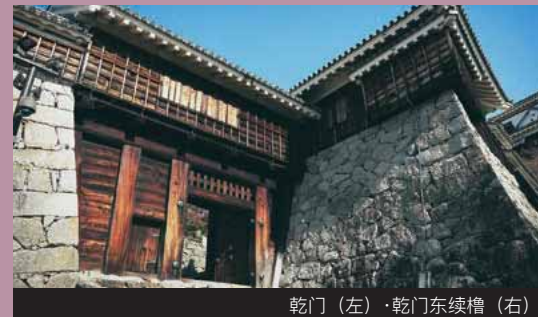
乾门（左）・乾门东续櫓（右）
